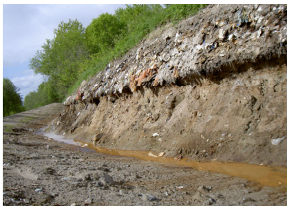
Lakvatten sipprar ur soptippen och tas om hand i en reningsanläggning.
